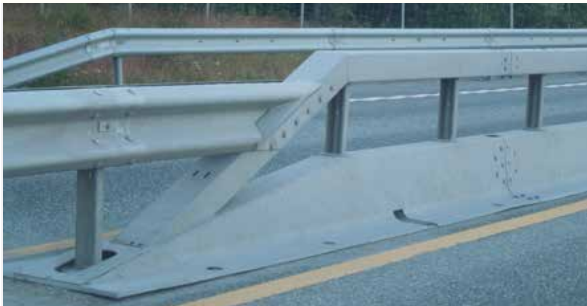
Midtdeler; tosidig overgang VG-W rekkverk
