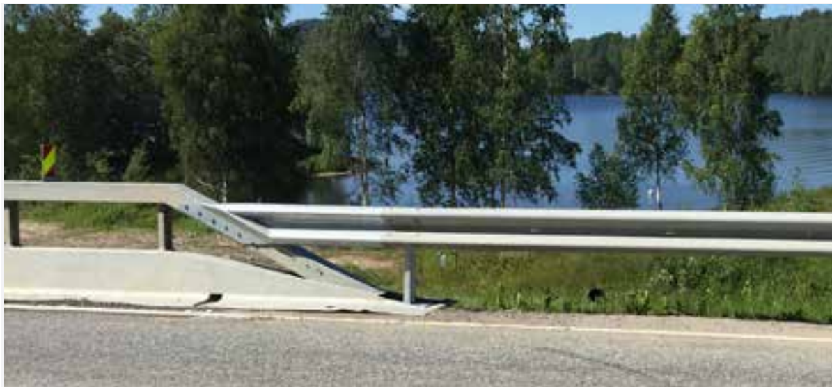
Vegkant; Ensidig overgang VG-W rekkverk
