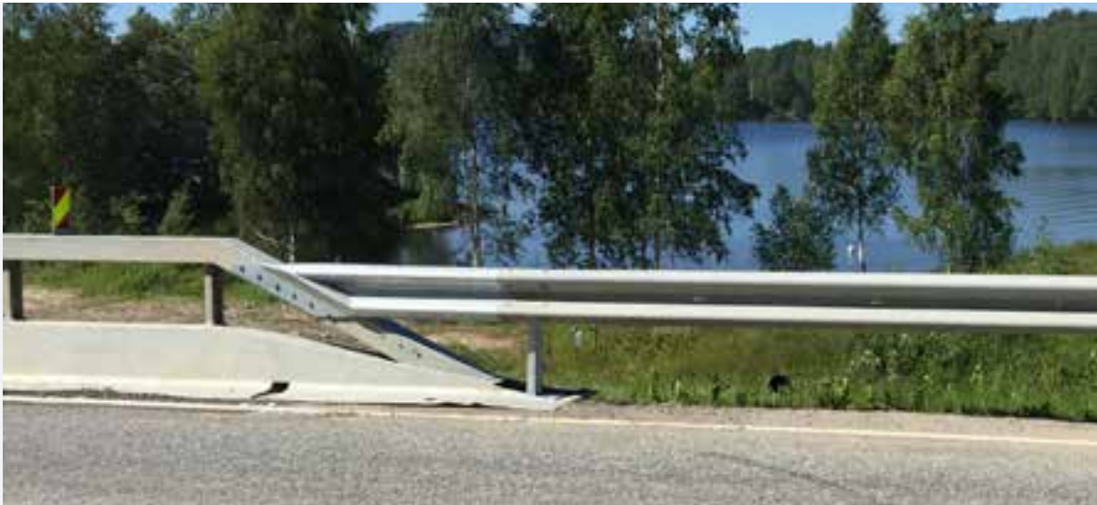
Vegkant; Ensidig overgang VG-W rekkverk
