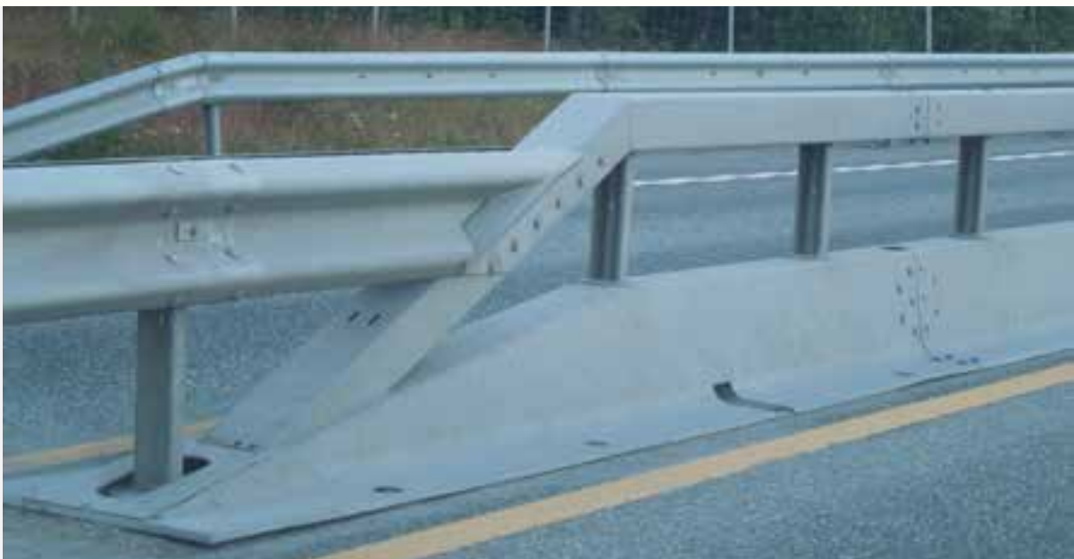
Middeler; tosidig overgang VG-W rekkverk
