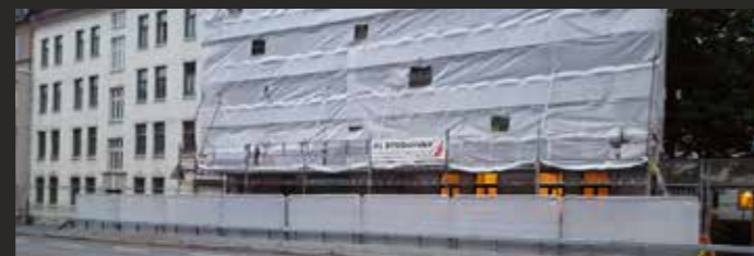
Anleggsgjerde med plastduk
