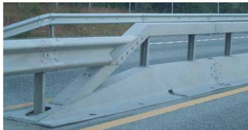
Midtdeler; tosidig overgang VG-W rekkverk
