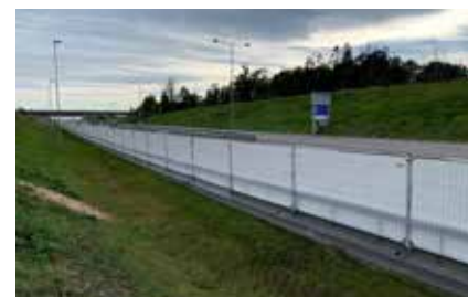
Anleggsgjerde med plastduk
