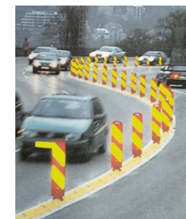
Klemmfix Hindermarkeringer montert på ledeskinne.
