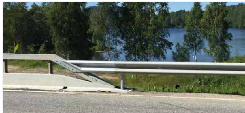
Vegkant; Ensidig overgang VG-W rekkverk
