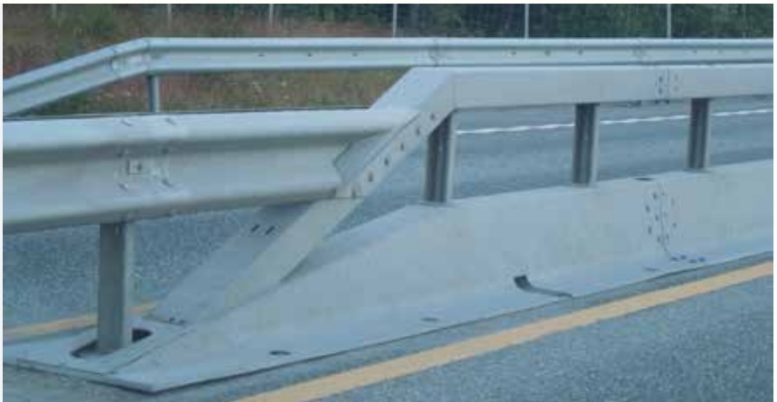
Midtdeler; tosidig overgang VG-W rekkverk
