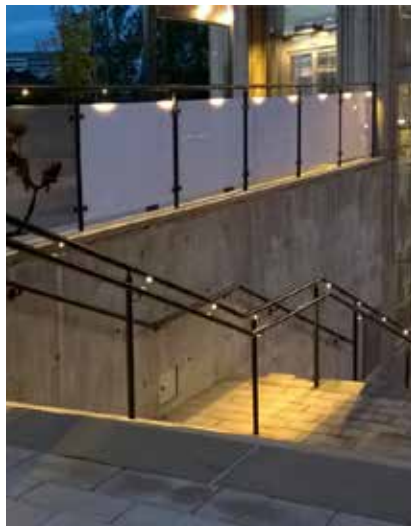
Opti rekkverk med LED-lys
