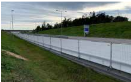
Anleggsgjerde med plastduk
