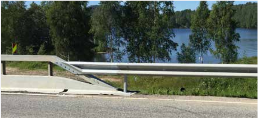
'Vegkant; Ensidig overgang VG-W rekkverk
