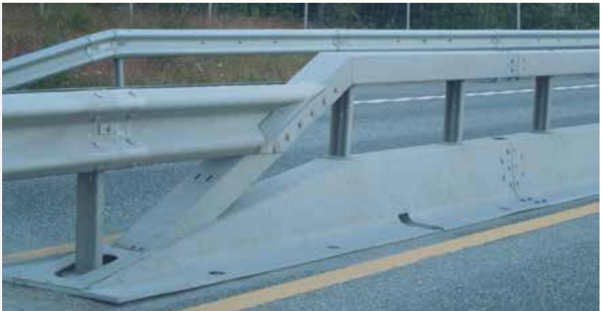
Midtdeler; tosidig overgang VG-W rekkverk
